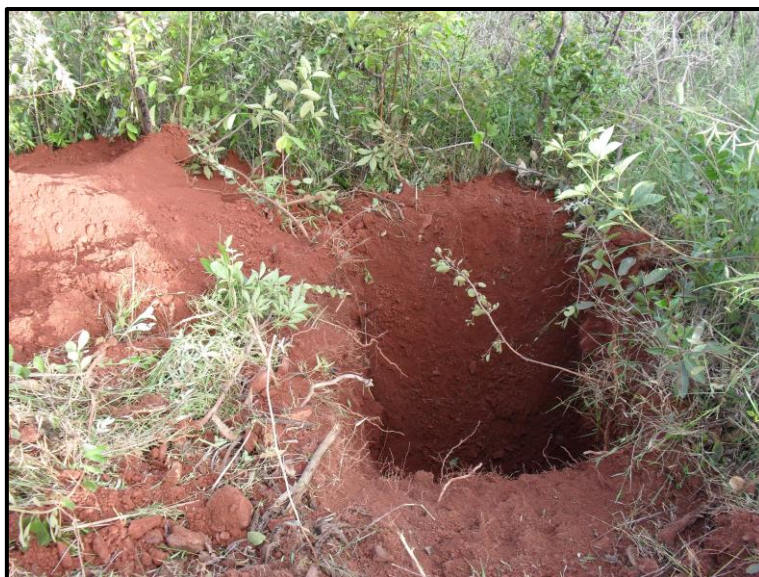
Figura 9: Abertura de trincheira na área. Fonte: GEPI, 2013.
