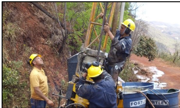
Figura 13: Equipe de sondagem, realizando a perfuração rotativa. Fonte: GEPI, 2013.
