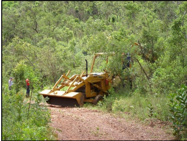
Figura 8: Retroescavadeira utilizada para abertura das trincheiras. Fonte: GEPI, 2013.
