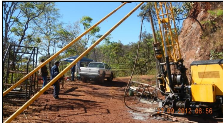
Figura 12 Equipe de sondagem, realizando a perfuração rotativa. Fonte: GEPI, 2013.
